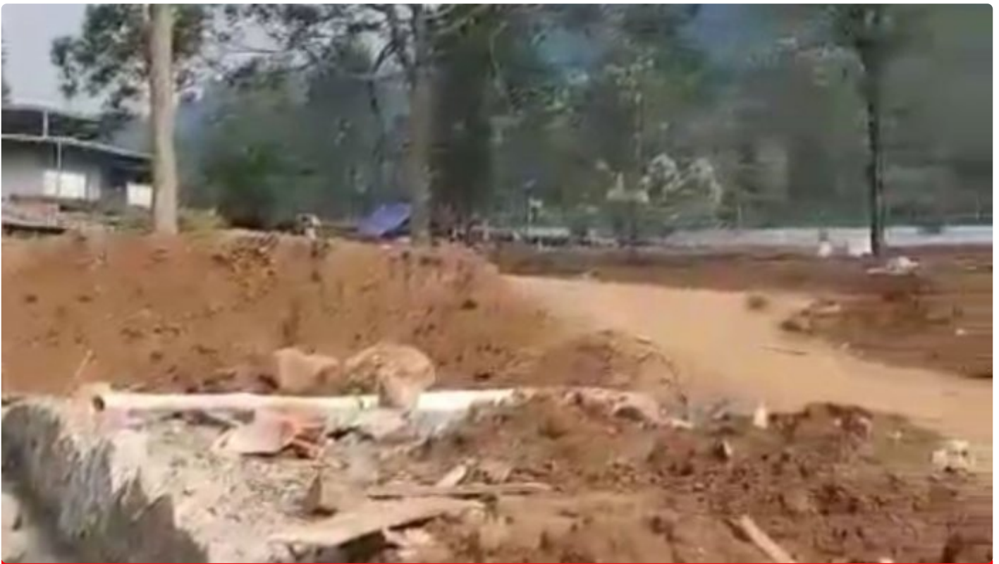
Photo: Kondisi Kebun tea yang sedang di bangun pariwisata
